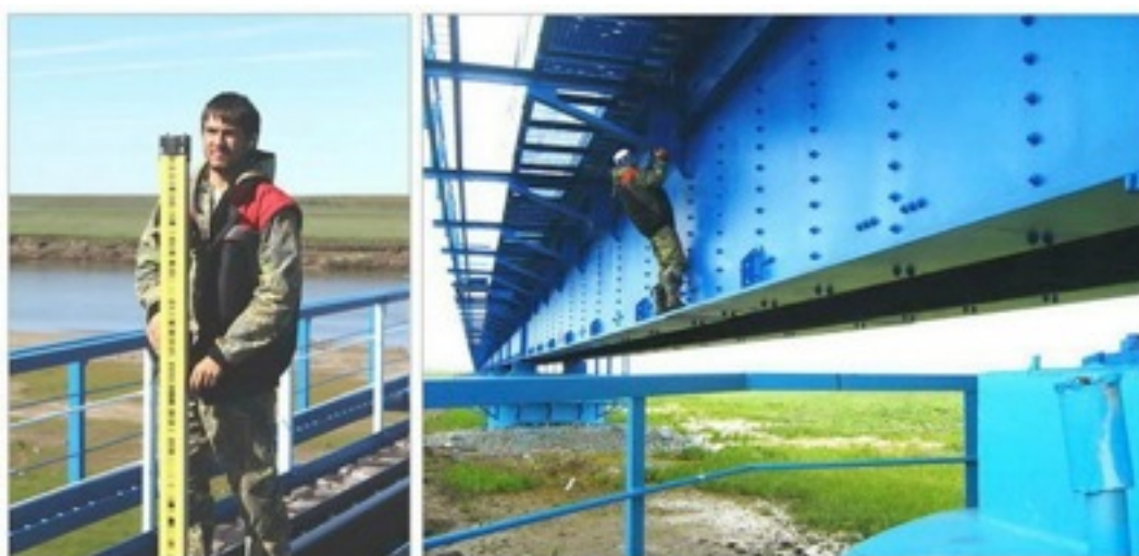
Ямал, мостовой переход железной дороги к Бованенковскому месторождению
